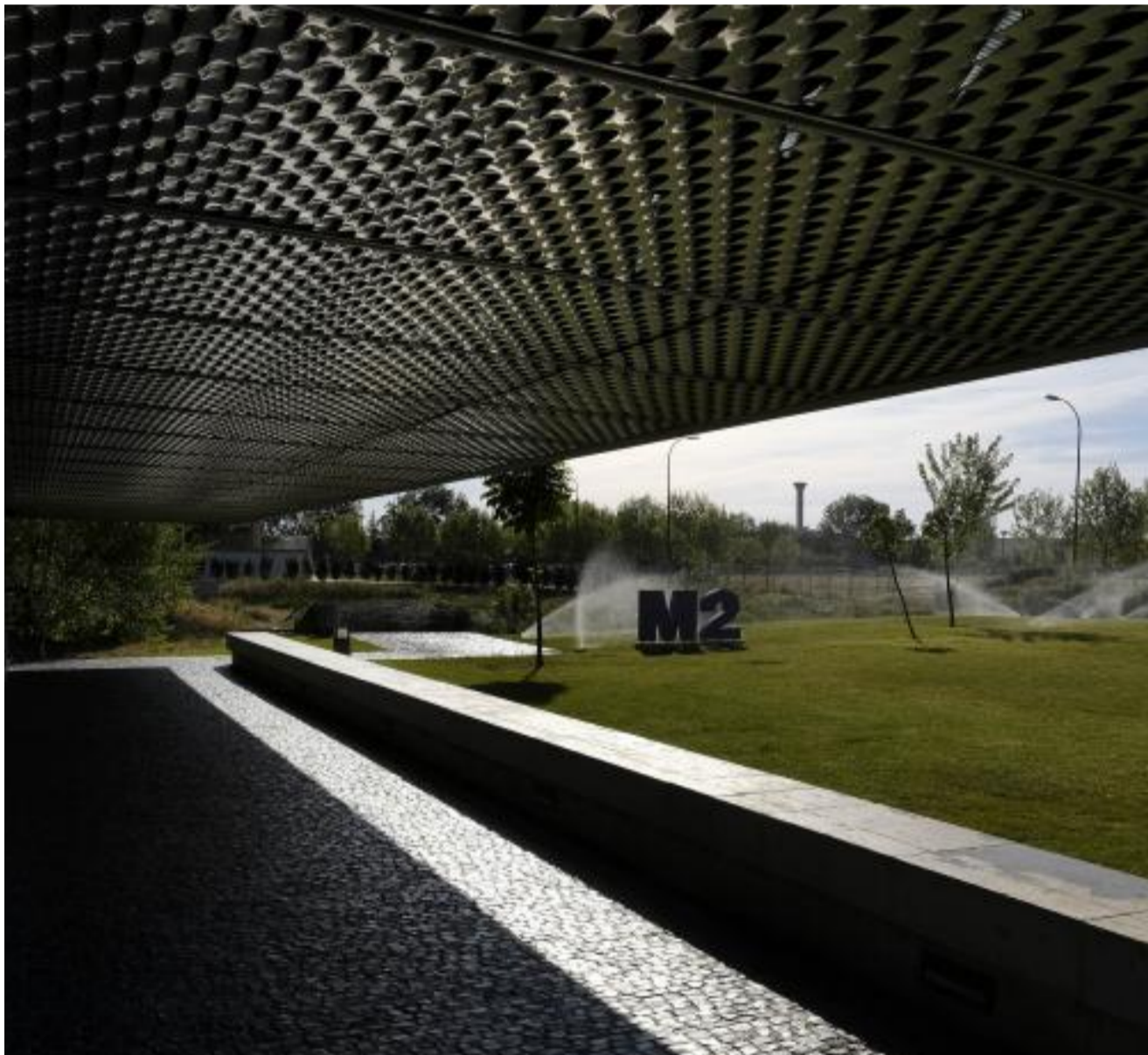
Exterior del edificio del M2 que alberga la sede de 8 empresas y el Centro de Procesamiento de Datos del Parque. / ENRIQUE CARRASCAL
